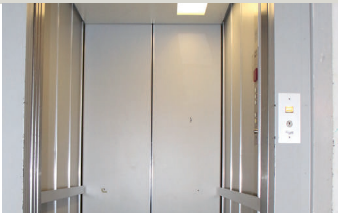
Lift, Schulhaus Risi
