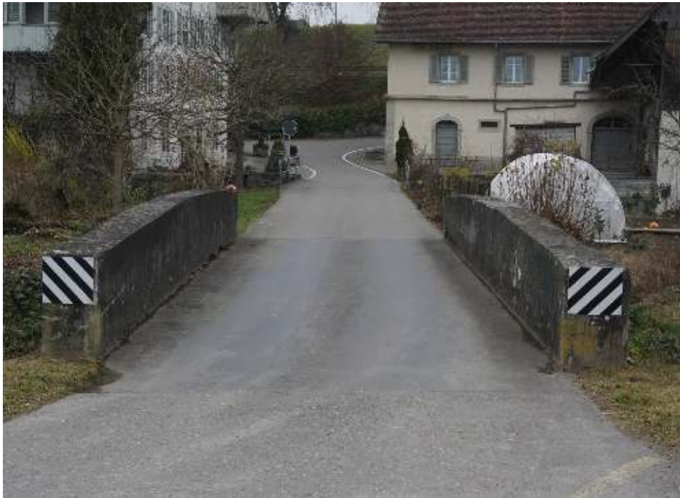
Blick Richtung Norden
