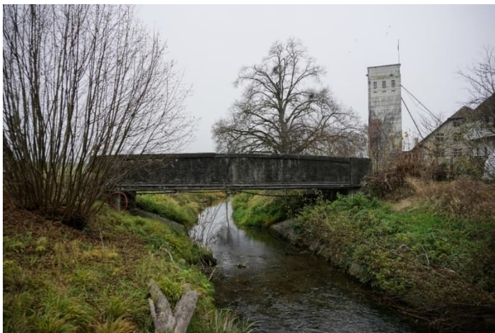
Blick in Fließrichtung der Bünz
